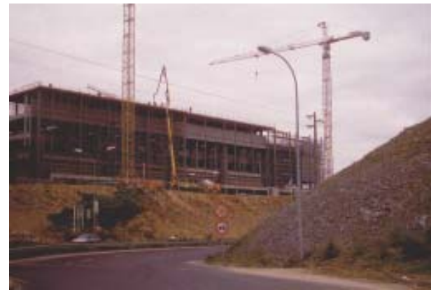
Uma fase das obras do novo Palácio da Justiça de Sintra
